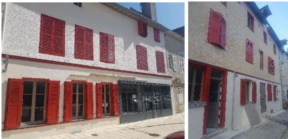
Façades avant et arrière (après travaux)
