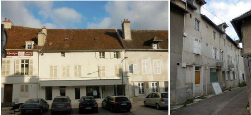
Façades avant et arrière ( avant travaux)
